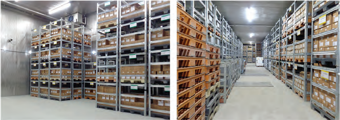
Figura 27 Câmara fria positiva (visão interna)
